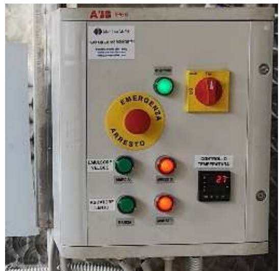
Controllo Temperatura con resistenze elettriche e sistema Avvio/Stop Misceleatore e Turbo Agitatore
